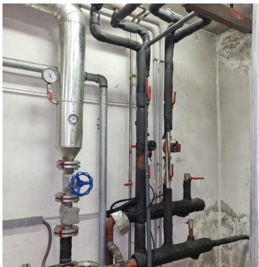
Slika 5. lijevo – cirkulacijske pumpe bojlera podrum i prizemlje; desno – cirkulacijske pumpe grijanje PTV-a.
