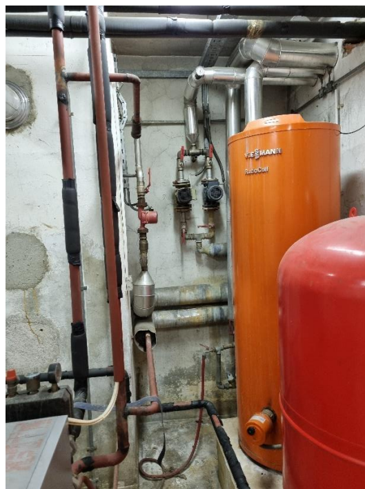
Slika 6. lijevo – cirkulacijske pumpe radijatorsko grijanje; desno – cirkulacijske pumpe recirkulacija PTV-a.
