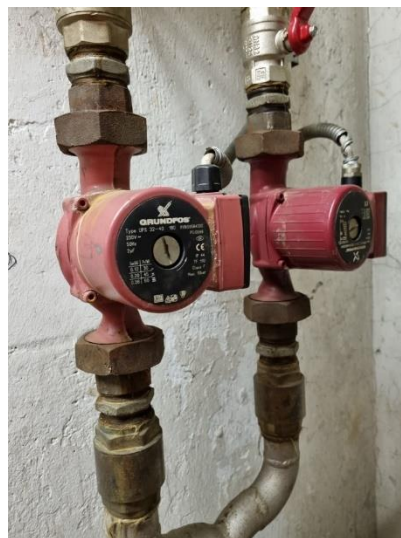
Slika 5. lijevo – cirkulacijske pumpe bojlera podrum i prizemlje; desno – cirkulacijske pumpe grijanje PTV-a.
