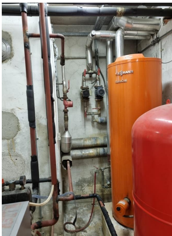
Slika 4. Spremnik potrošne tople vode Viessmann RudoCell, V=300 lit.
