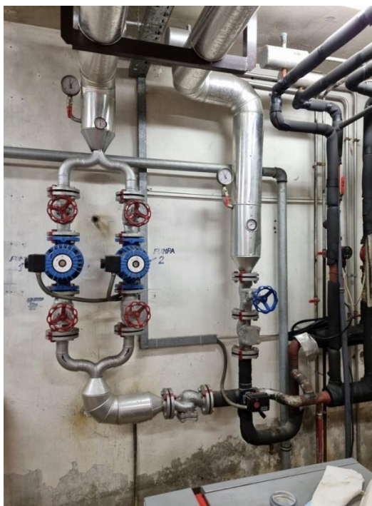
Slika 6. lijevo – cirkulacijske pumpe radijatorsko grijanje; desno – cirkulacijske pumpe recirkulacija PTV-a.
