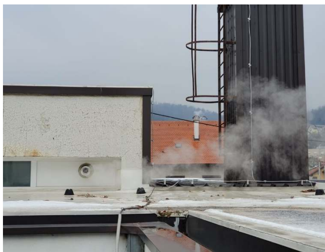
Slika 2. Dimnjak samostojećeg kotla Viessmann Vitogas 100
