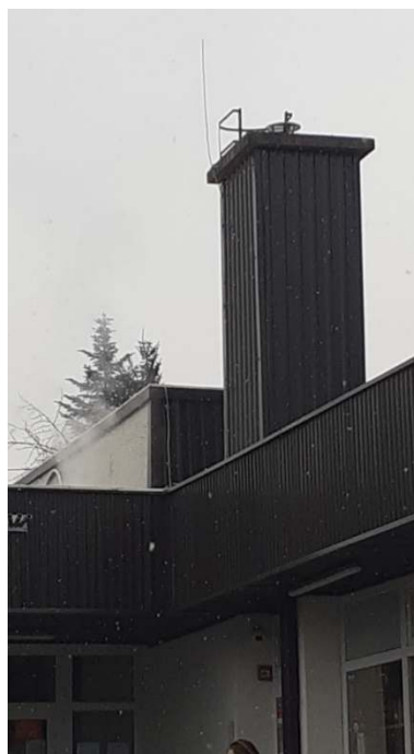
Slika 2. Dimnjak samostojećeg kotla Viessmann Vitogas 100
