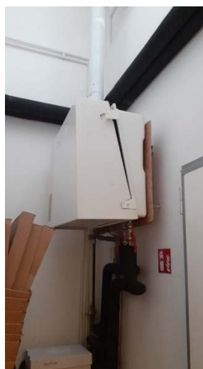
Slika 2. Dimnjak samostojećeg kotla Viessmann Vitogas 100
